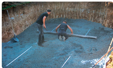
<06> Mise à niveau du fond
