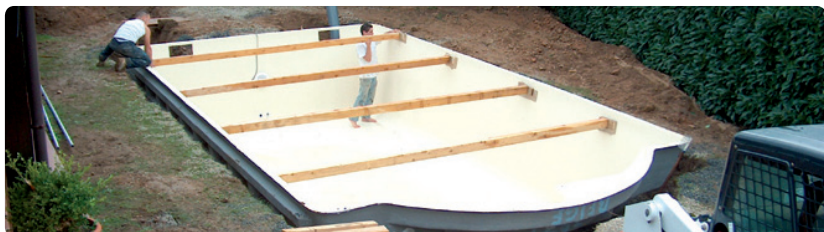
<08> Installation de la coque dans son trou
