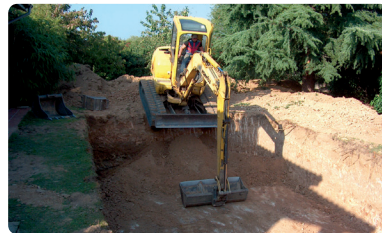
<03> Déblaiement des terres
