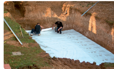
<04> Mise en place du géo-textile
