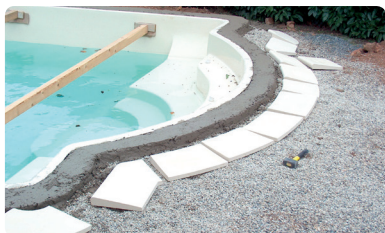
<09> Installation des margelles
