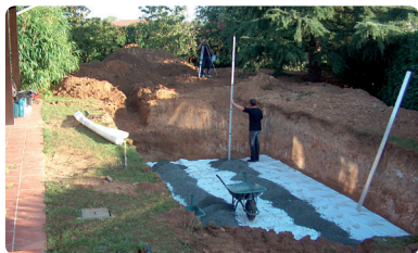
<05> Remblaiement de graviers
